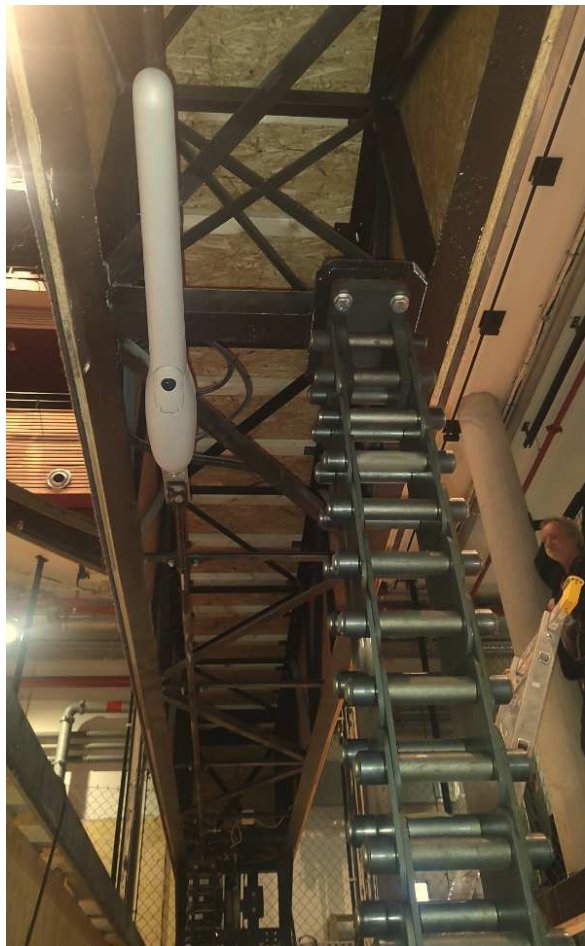
Plošina 3: nefunkční vratový motor
